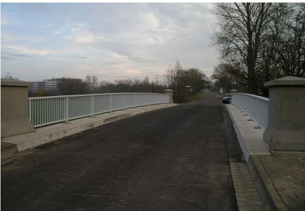
<p>Überbau nach der Verkehrsfreigabe</p>
