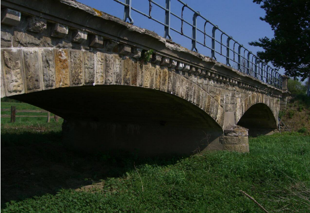
<p>Alte Brücke vor der Sanierung</p>
