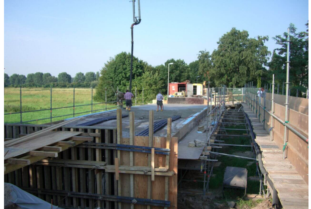
<p>Betonage der Fahrbahnplatte</p>
