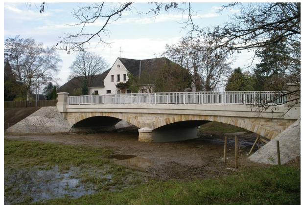
<p>Ansicht der sanierten Flutbrücke</p>
