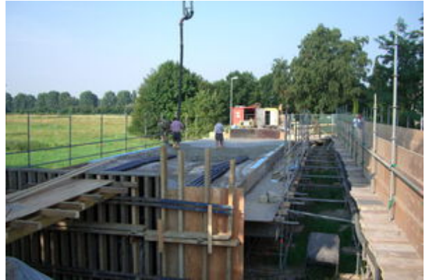
Betonage der Fahrbahnplatte
