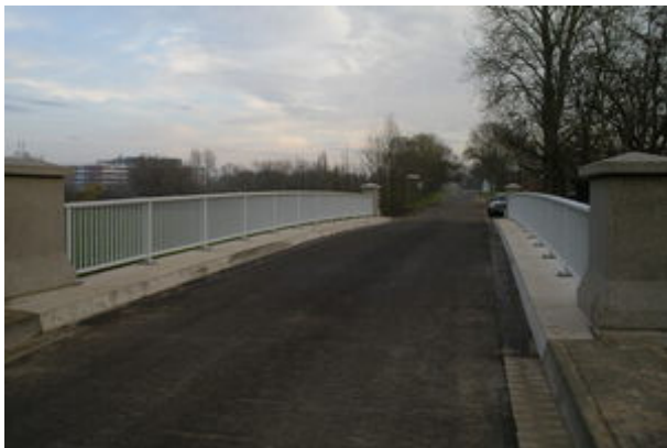
Überbau nach der Verkehrsfreigabe
