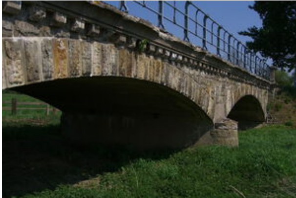
Alte Brücke vor der Sanierung
