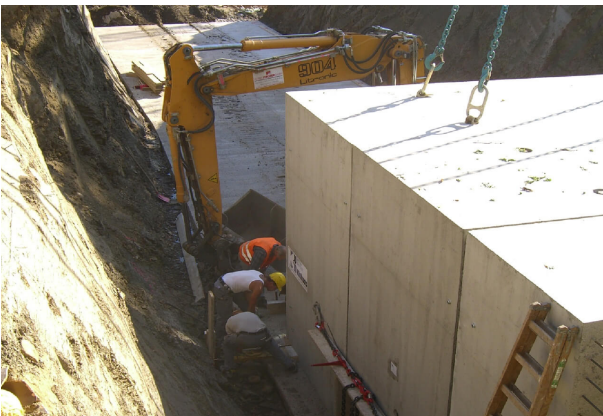
<p>Tunnel als Verbindung zwischen 2 Gebäuden</p><p>Verfüllung und Übergang an das neue Gebäude</p>
