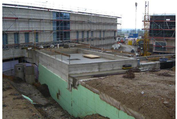
<p>Tunnel als Verbindung zwischen 2 Gebäuden</p><p>Verfüllung und Übergang an das neue Gebäude</p>
