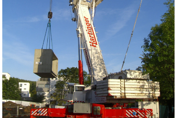
<p>Einbau der Tunnелеlemente mit einem Autokran</p>
