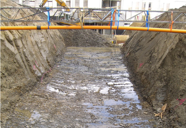
<p>Aushubarbeiten für die Tunneltrasse</p>
