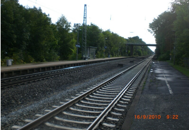
Alter Bahnhof mit niedrigen Bahnsteigkanten
