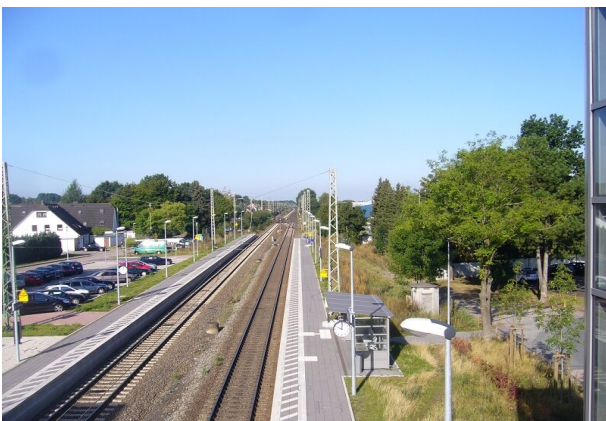
Neuer Bahnhof mit Gefahrenbereichmarkierung
