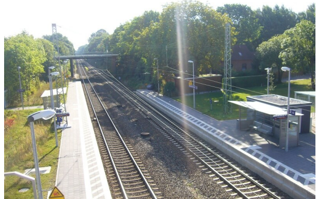
Neuer barrierefreier Bahnhof mit Wartehallen
