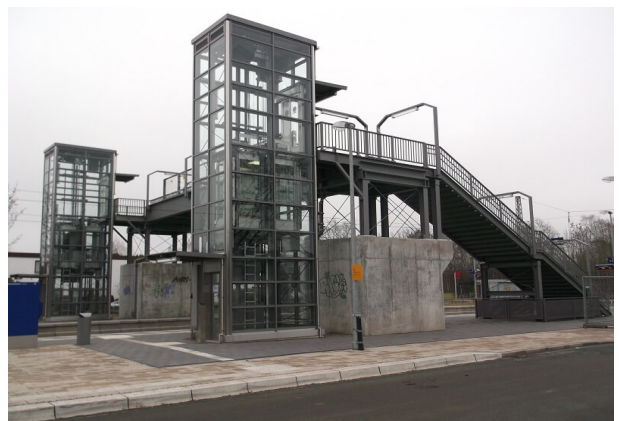
Aufwendige Personenunterführung mit Aufzügen
