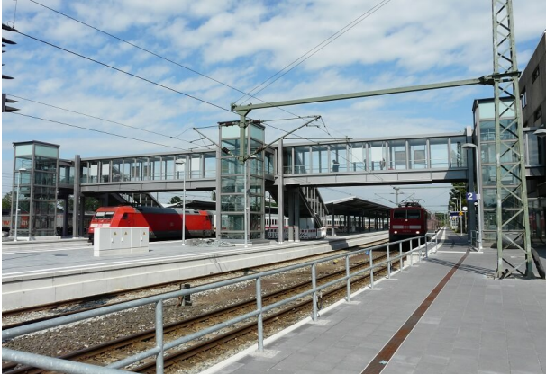
Sanierte Personenüberführung über die Gleise 2-4 Neue Einhausung Personenüberführung und Treppenanlagen
