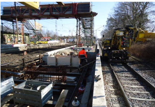
Herstellen der Brückenfundamente am Bahnsteig Gleis 2/3
