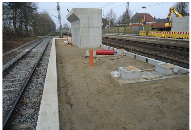
Auflagerturm für Fußgängerüberführung
