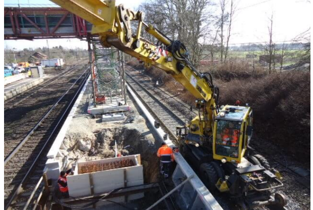
Arbeiten am Mittelbahnsteig
