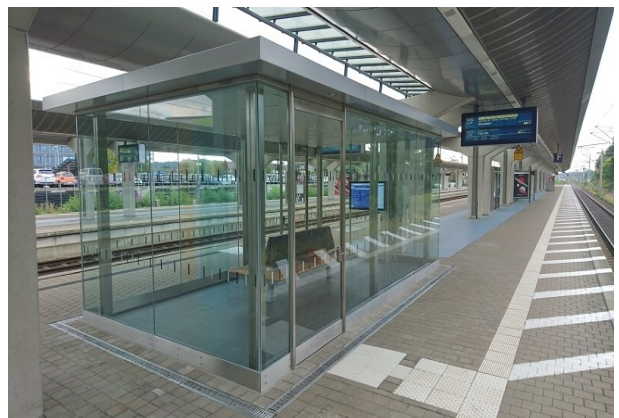
Blindenleitsystem Bahnsteig Gleis 1/2
