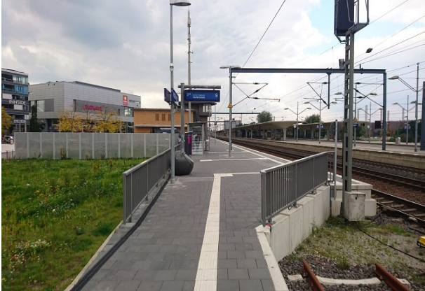
Verbindung Haus- und Außenbahnsteig
