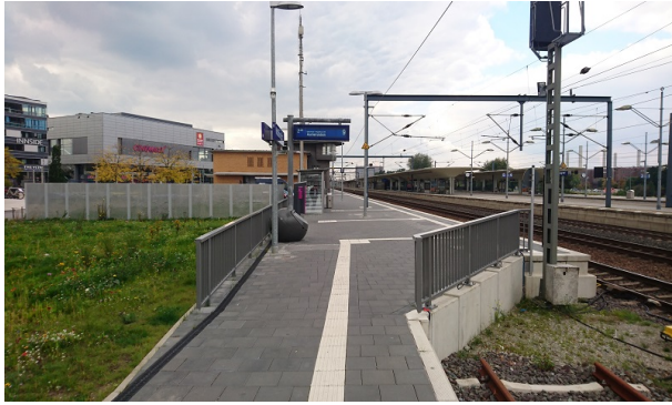
Verbindung Haus- und Außenbahnsteig
