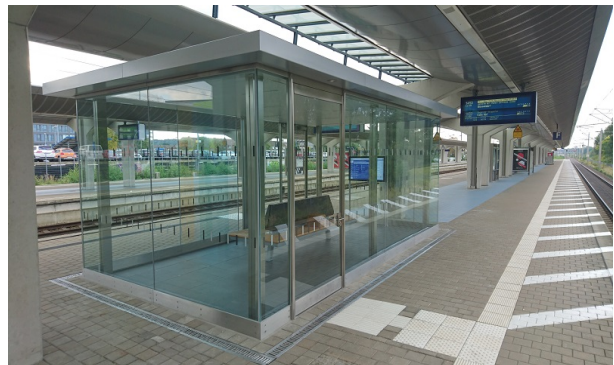
Blindenleitsystem Bahnsteig Gleis 1/2
