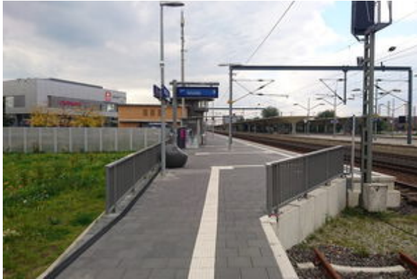
Verbindung Haus- und Außenbahnsteig
