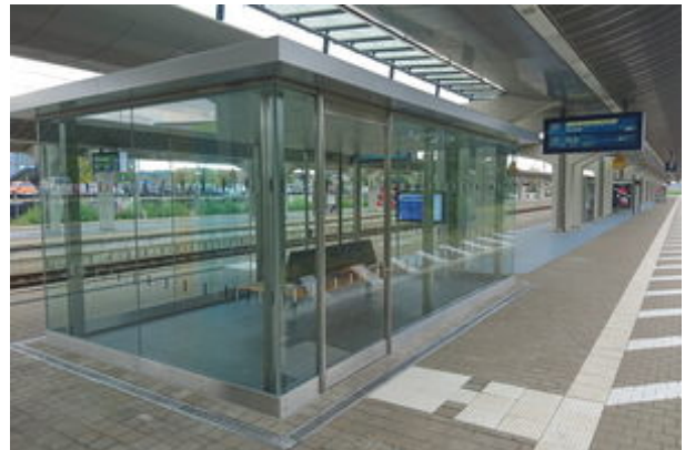
Blindenleitsystem Bahnsteig Gleis 1/2
