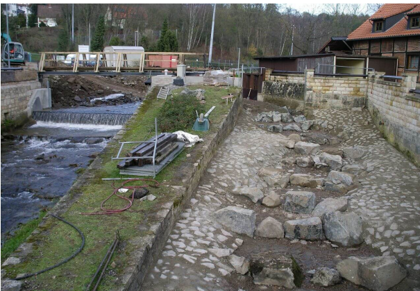
<p>Setzen der Natursteine in der Fischaufstiegsanlage</p>
