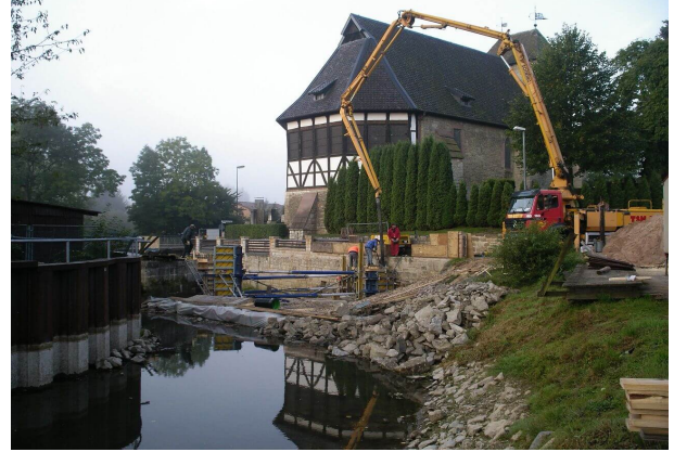
<p>Betonieren der Wehrwände mit Betonpumpe</p>
