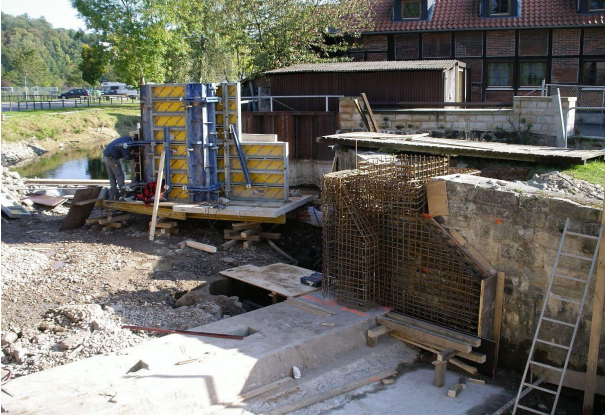
<p>Bewehren und Einschalen der Wehrwände</p>
