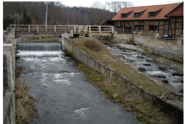
<p>Wehranlage und Fischtreppe sind in Betrieb</p>
