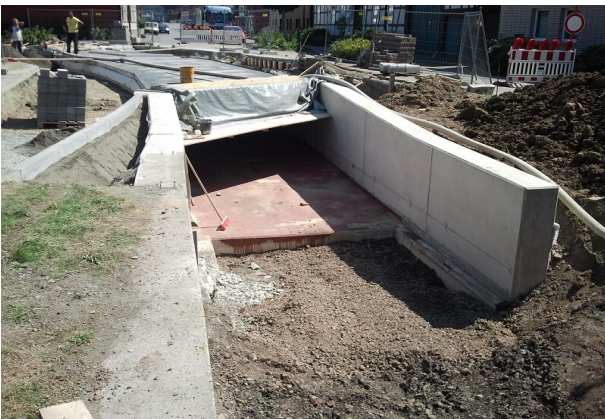
Zwischenzustand neues Bauwerk, Gewässersohle
