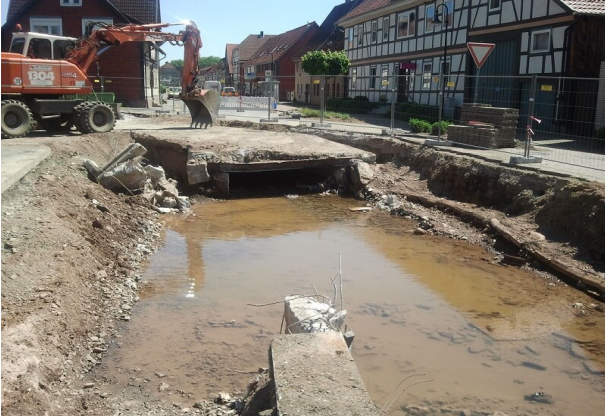
Abbruch des Bestandsbauwerkes
