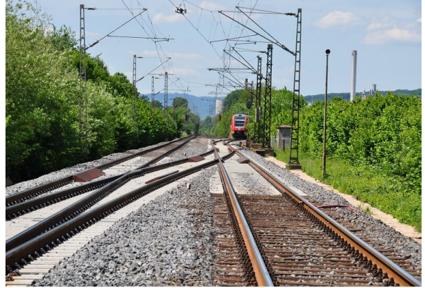
Weiche 12 nach Fertigstellung
