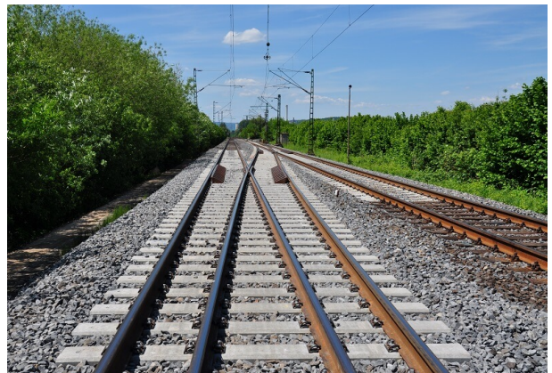
Weiche 13 nach Fertigstellung
