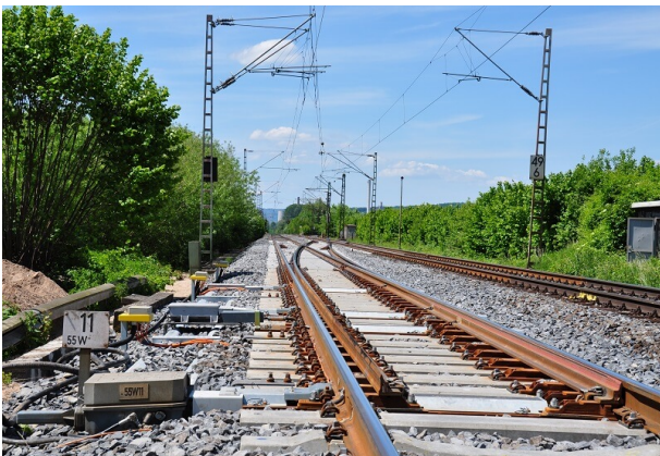
Weiche 11 nach Fertigstellung
