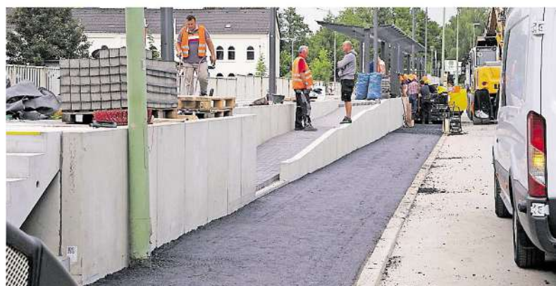
Am Donnerstagmorgen laufen an der Schneidmühle bereits die Asphaltarbeiten, während am Rathaus die Randsteine für die Rampe gesetzt werden.
