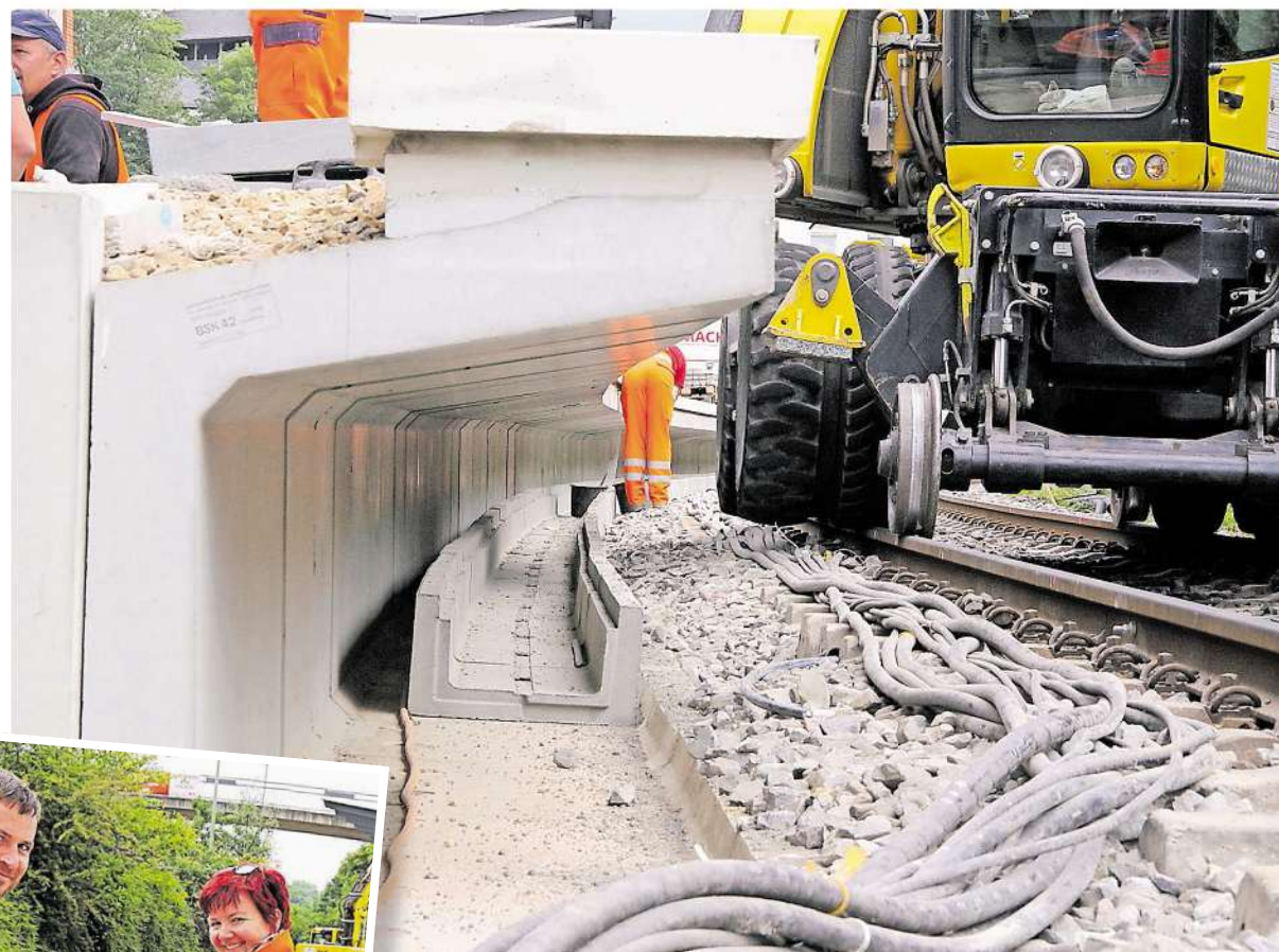
Bei S-Bahnstrecken dient der Spalt als Schutzraum am Gleis, bei der Euregiobahn als Kabelkanal. Ingrid Eisenburger und Daniel Karpenko sind zuversichtlich, dass am Samstag die Euregiobahn wieder pünktlich verkehrt.
