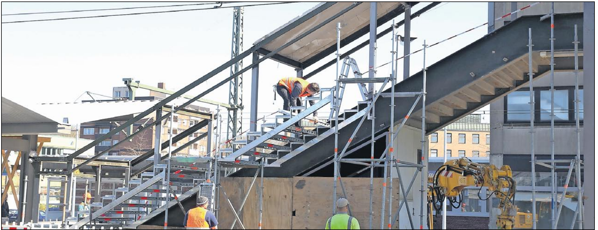
Stufe für Stufe: Die provisorische Treppe wird montiert.
