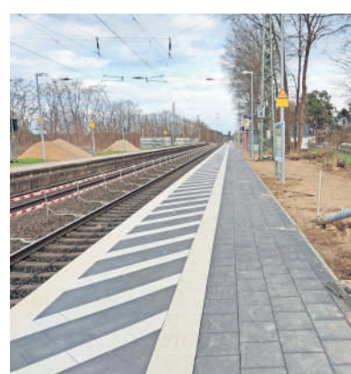
Der Bahnsteig am Gleis 1 ist bereits verlängert und neu gepflastert. Hinter dem Schützenhaus (rechts) sind dafür Spundwände gesetzt worden.
