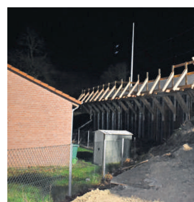
Der Bahnsteig am Gleis 1 ist bereits verlängert und neu gepflastert. Hinter dem Schützenhaus (rechts) sind dafür Spundwände gesetzt worden.
