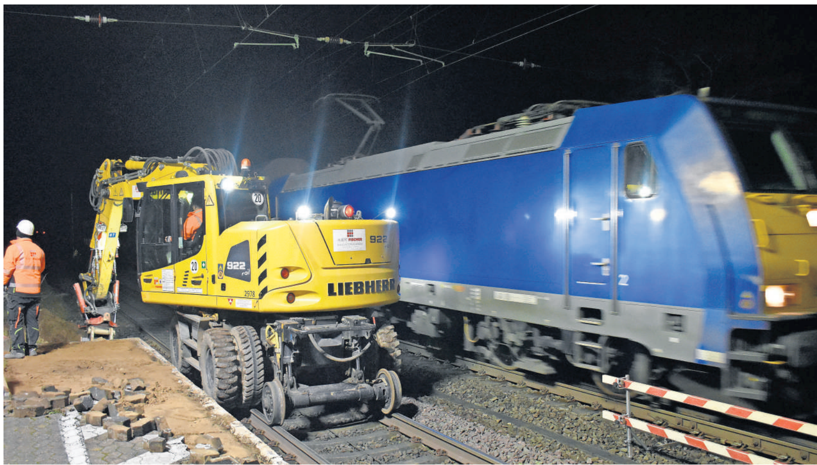
Auf Gleis 2 wird der Bahnsteig abgerissen und erneuert – daneben saust ein Metronom durch den Bahnhof.
