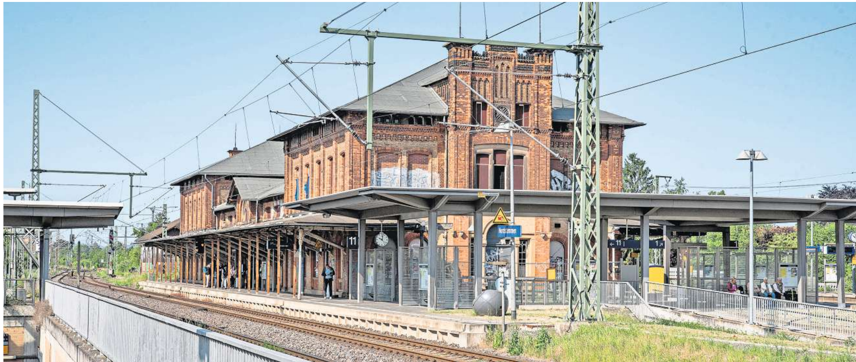
Das gesamte Bahnhofsgebäude soll abgetragen und auf der linken Seite der Bahngleise mit neuem Kern aber gleichem Zuschnitt wieder aufgebaut werden.
