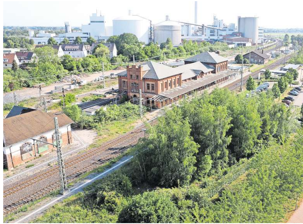
Das denkmalgeschützte Bahnhofsgebäude soll auf die Grünfläche im Vordergrund versetzt werden. FOTO: STUMPE
