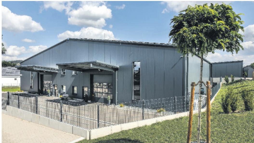
Bauqualität zum garantierten Festpreis: A.F. Gewerbebau stellt sich den Anforderungen, die speziell der Gewerbebau mit sich bringt, und blickt auf einen hervorragenden Ruf.
