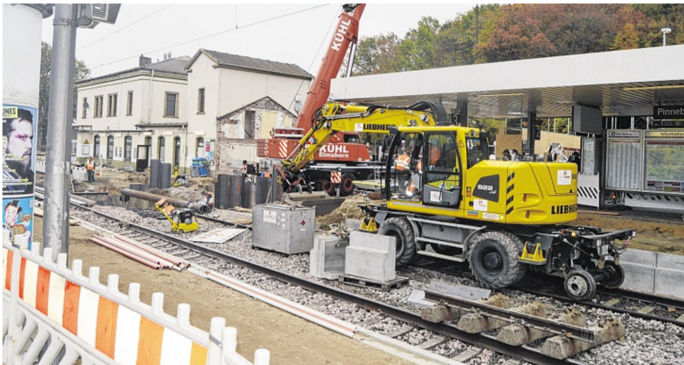
Die Bagger rollen im Dauereinsatz: Noch bis Ende des Monats halten die Hauptbauarbeiten am Pinneberger Bahnhof an. FOTO: DUVENECK
