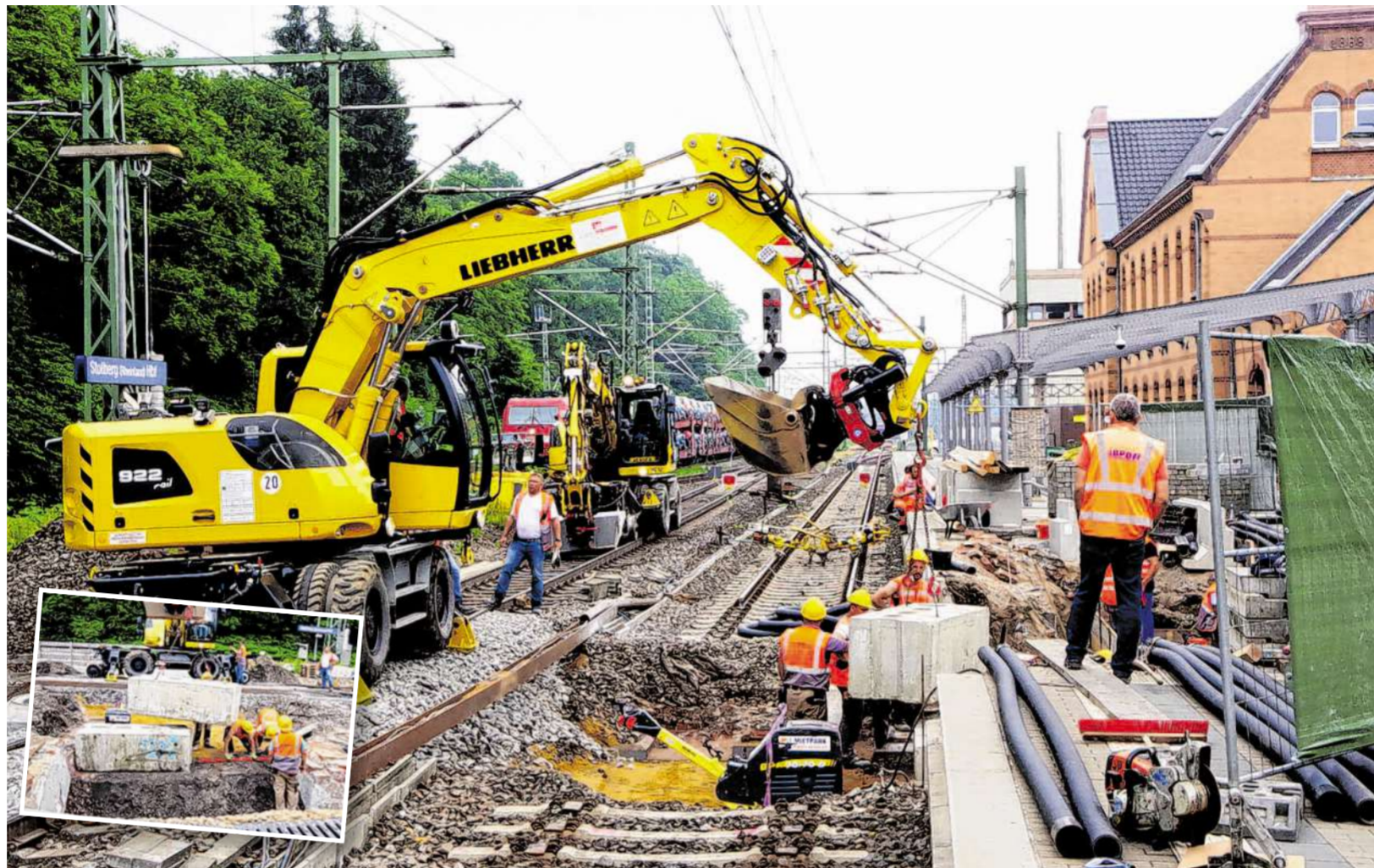
Pünktlich fertig: Bahnsteig aufbrechen, Schienen unterbrechen, Tunnel verfüllen und Schienen sowie Bahnsteig wiederherstellen: Am Wochenende starteten aufwendig die Arbeiten für den neuen „Skywalk“ im Stolberger Hauptbahnhof. Fotos: J. Lange
